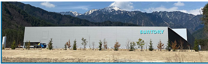
「北アルプス信濃の森工場」の外観
